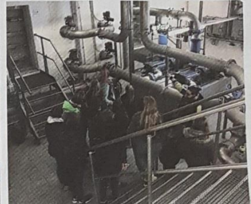
Sauberes Trinkwasser: SchülerInnen besichtigten die Aufbereitungsanlage der Kreiswerke in Hasselroth.
