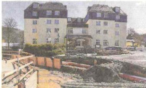
Am Kesselbach wird vor der Alloheim Seniorenresidenz in Bad Elster gebaut. Die Walther-Rathenau-Straße ist dafür gesperrt. FOTO: CHRISTIAN SCHUBERT
