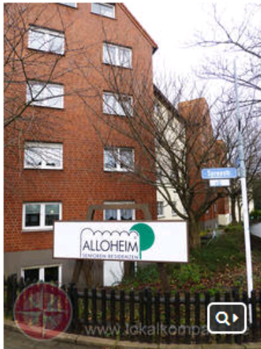
Die Alloheim Senioren-Residenz Körne wird ab März 2018 umfassend saniert.
